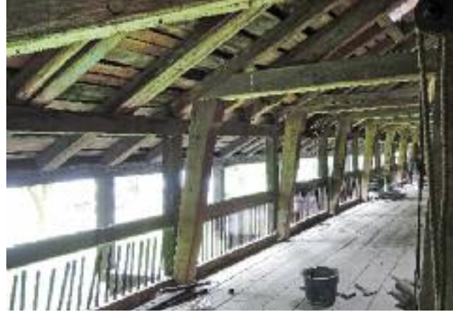
Die ersten Rückbau-Arbeiten an der Appretur fanden bereits statt. Nun soll hier etwas völlig Neues entstehen
